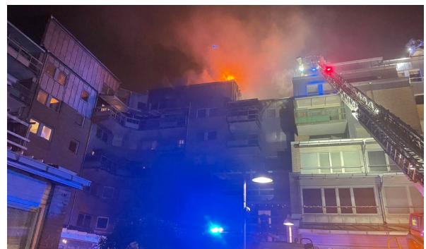
Vindsbrand i flerbostadshus. Foto: RSG
