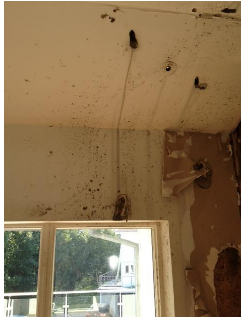
Pagube cauzate de hidroperforare
