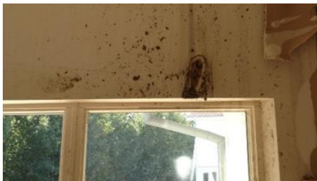
Pagube cauzate de perforare și apă
