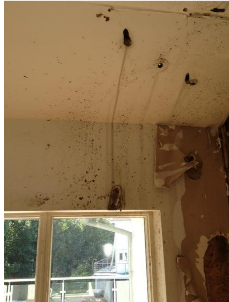
Vom Schneidlöschgerät verursachte Schäden
